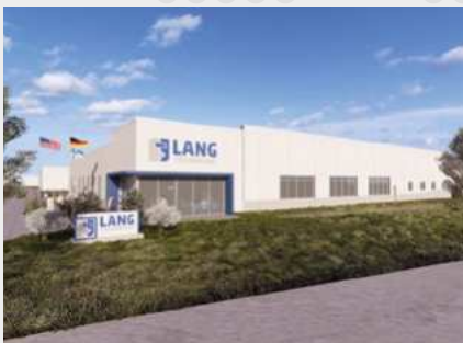
→ LANG Technik États-Unis Nouveau bâtiment d'entreprise 2025
